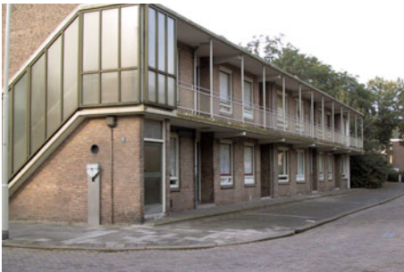
Serooskerkestraat huidige situatie, op termijn: sloop en nieuwbouw
