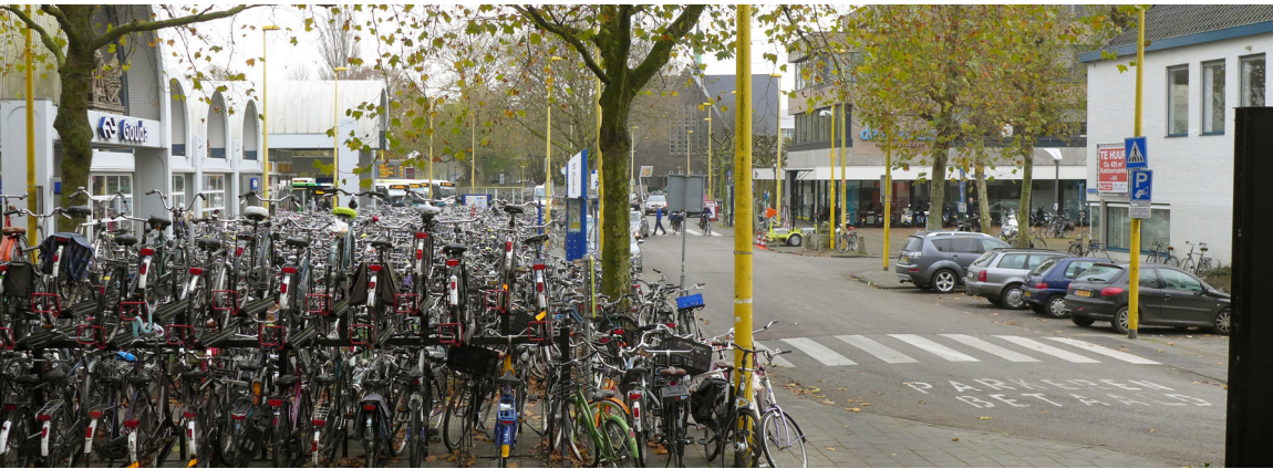
Bestaande situatie zuidelijk stationsplein
