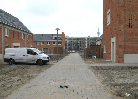
Tuin op het zuiden - west: Ovezandepad in wording
